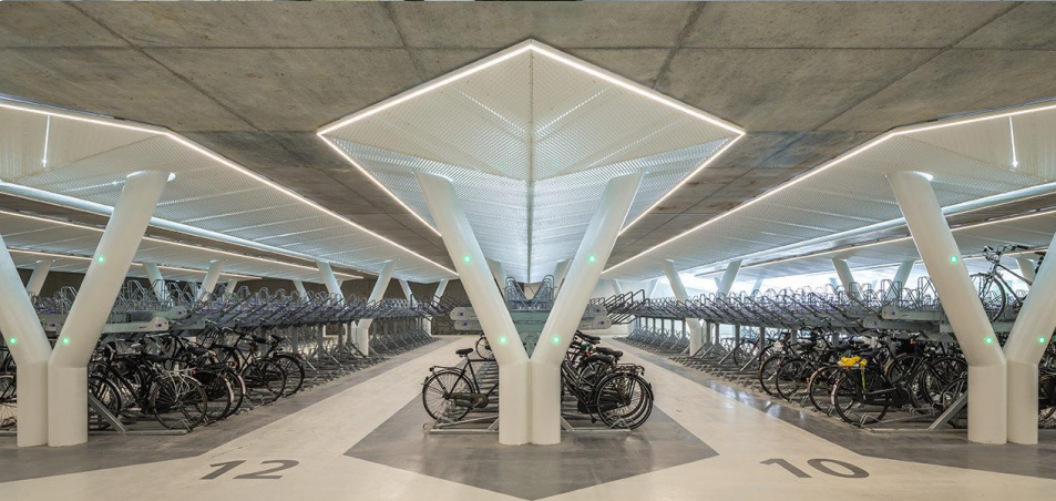
Ondergrondse fietsparkeergarage Strawinskyaan
